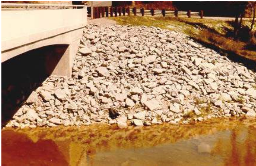
Figure 8.9(d) Random Rip-Rap Slope Protection
