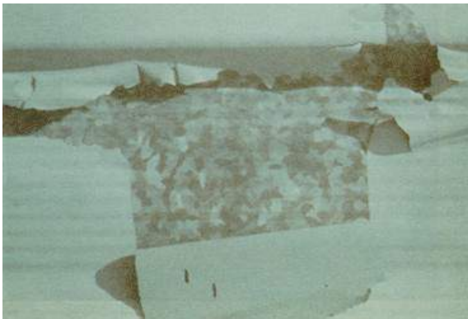
Figure 2.8.2(d) Peeling
