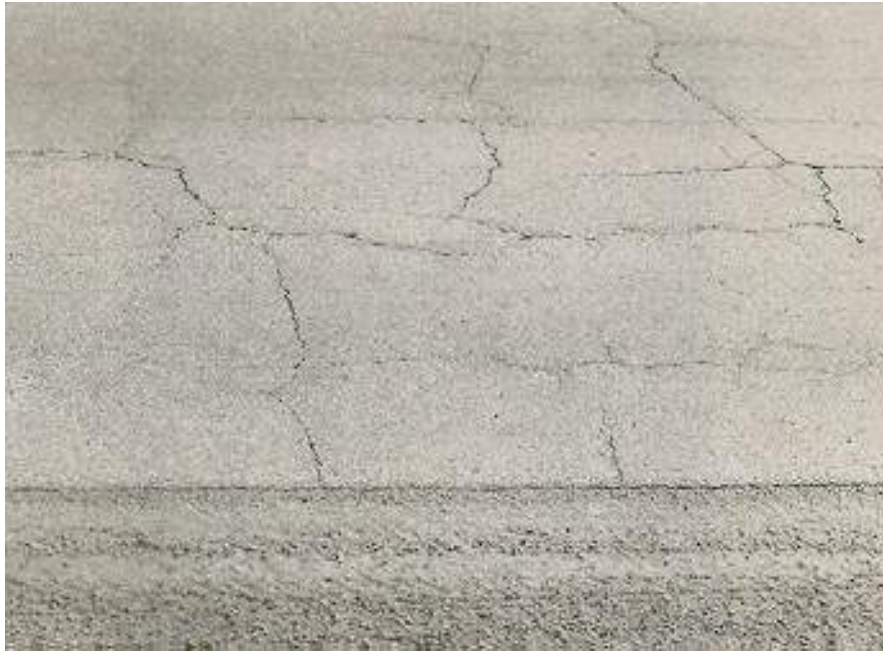
Figure 2.7.1(d) Light Map Cracks
