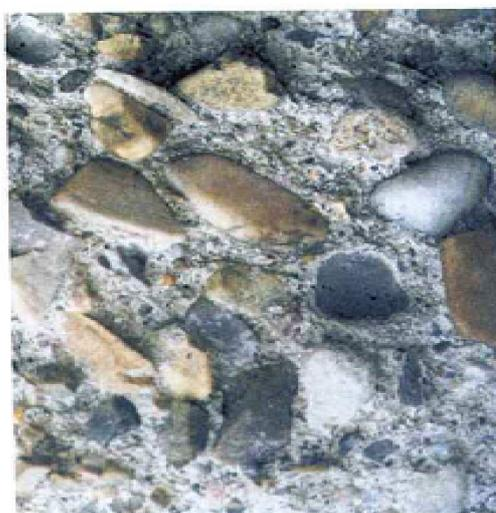
Figura 2.13 – Aspecto de um concreto que pode ter sido degradado por chuva ácida, mostrando a degradação da matriz de cimento e expondo completamente os agregados
