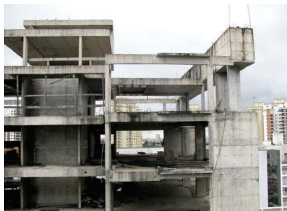
FOTO 4 – MANCHAS ESCURAS DA IMPREGNAÇÃO DE FULIGENS E PROLIFERAÇÃO DE MICRO-ORGANISMOS NA SUPERFÍCIE DO CONCRETO APARENTE DA ESTRUTURA INACABADA EM OBRA NA CIDADE DE SÃO PAULO
