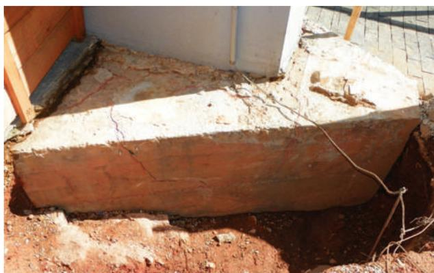
FOTO 3 – BLOCO DE FUNDAÇÃO COM REAÇÃO ÁLCALI-AGREGADO
