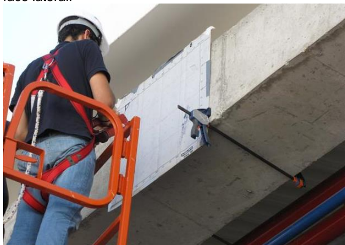
Figura 9: Ensaio de deteção de armaduras numa face lateral de uma viga.
