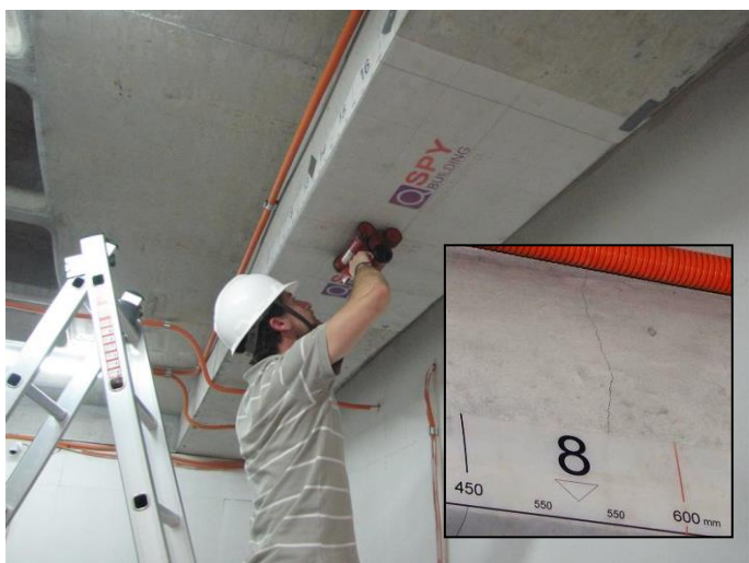
Figura 3: Ensaio de detecção de armaduras junto de zona fissurada.
