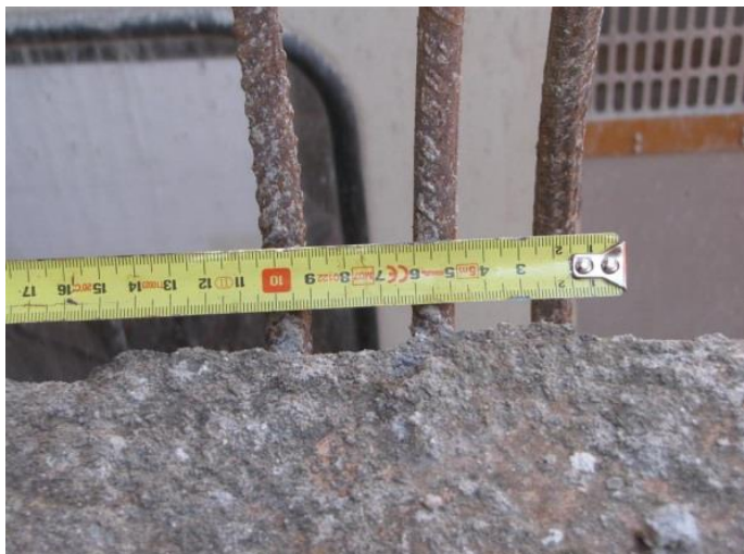
Figura 2: Varões de espera diferentes dos especificados em projeto.
