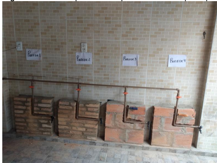
Figura 4.5 — Instalação da tubulação de 20 mm nos protótipos
