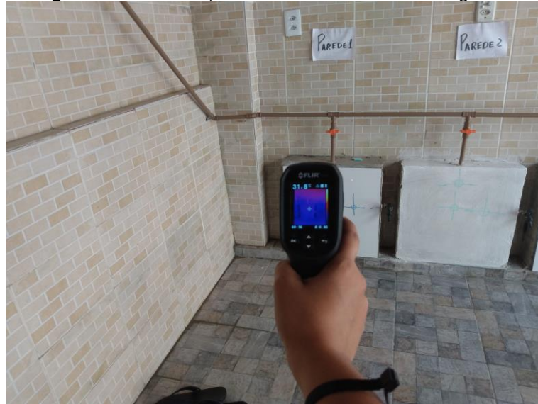
Figura 4.11 — Medição utilizando a câmera termográfica
