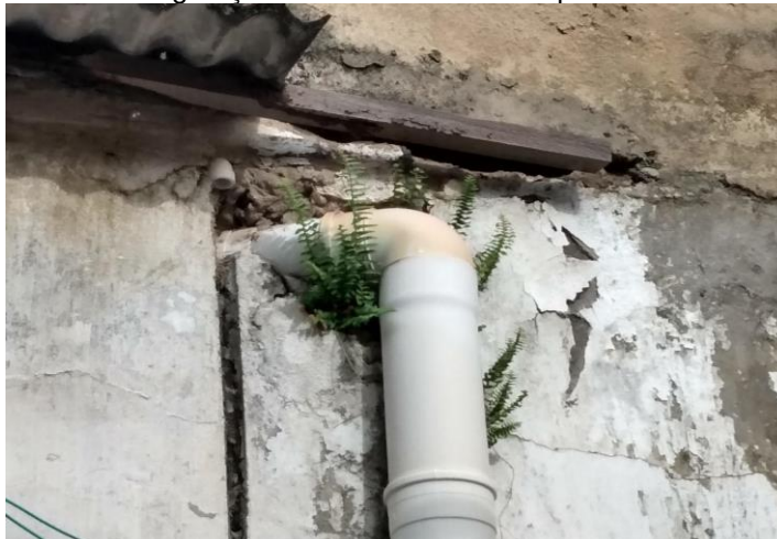
Figura 3.5 — Vegetação no arremate do tubo passante na elevação
