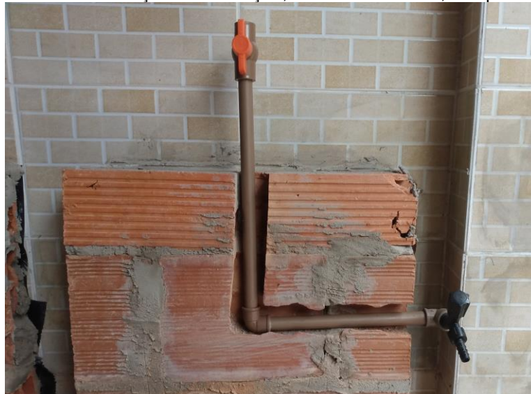
Figura 4.3 — Instalação da tubulação, em formato de “L”, nos protótipos.
