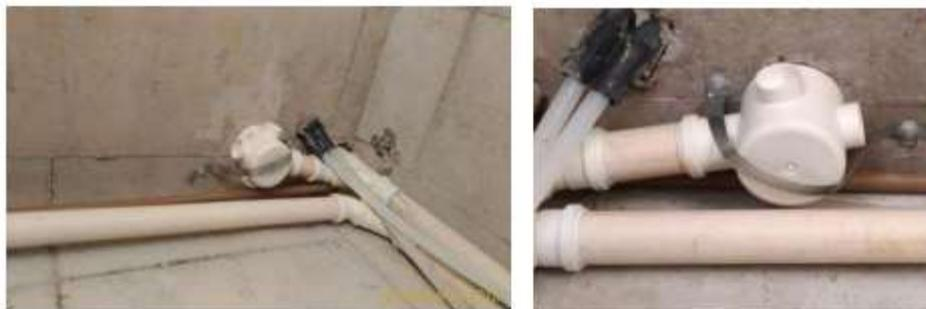
**Figura 117 - Fixação dos ralos 150mm com fita perfurada – preferência em sistema X**
