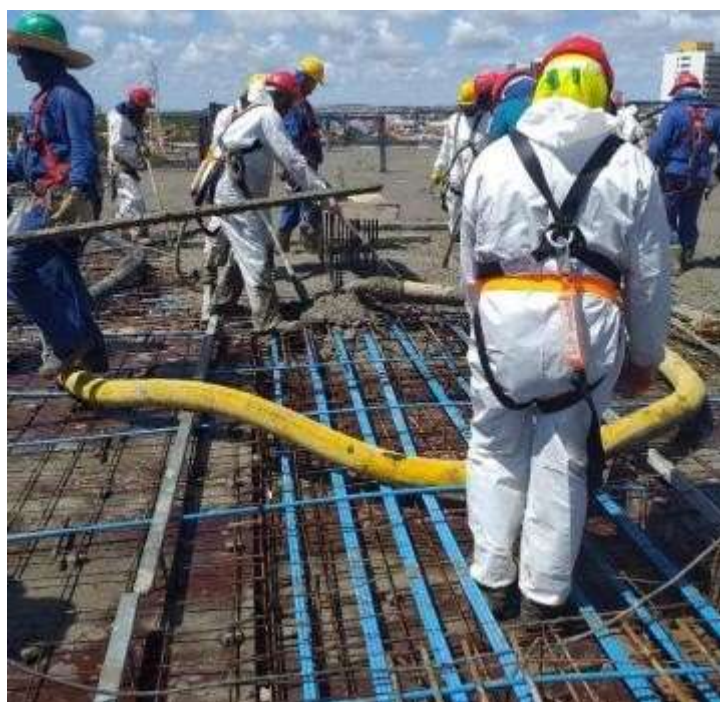
Figura 25 - Etapa de adensamento do concreto
