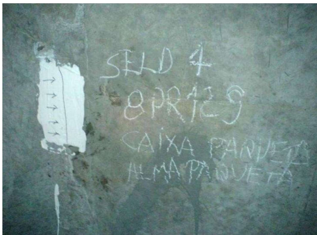
Figura 43 - Fissuras na região da alma
