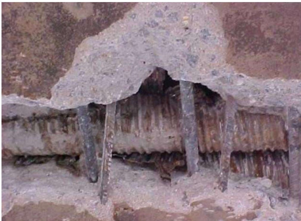
Figura 45 - Corrosão encontrada a partir do R.I.M.T.
