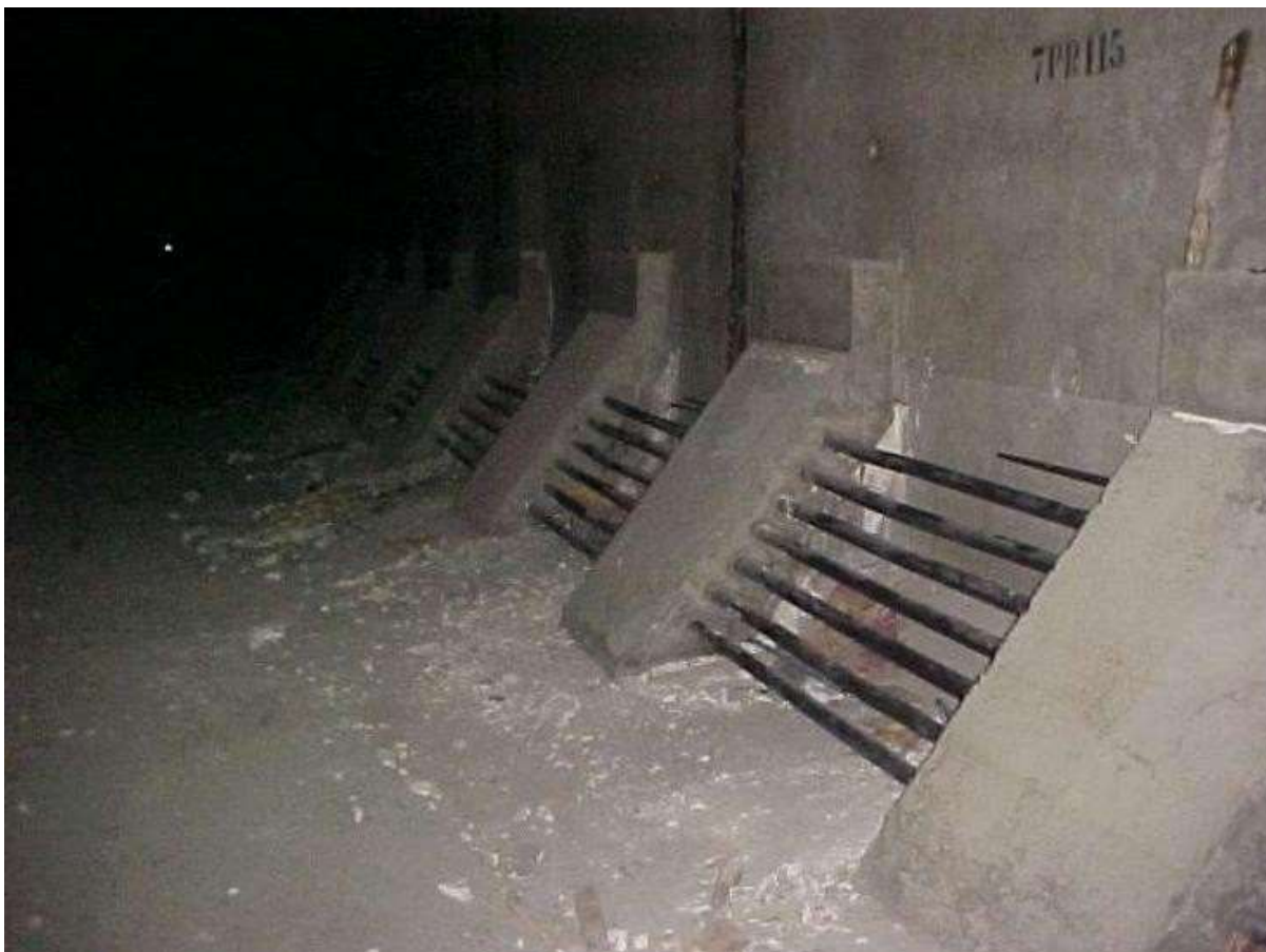
Figura 47 - Reforço por protensão externa
