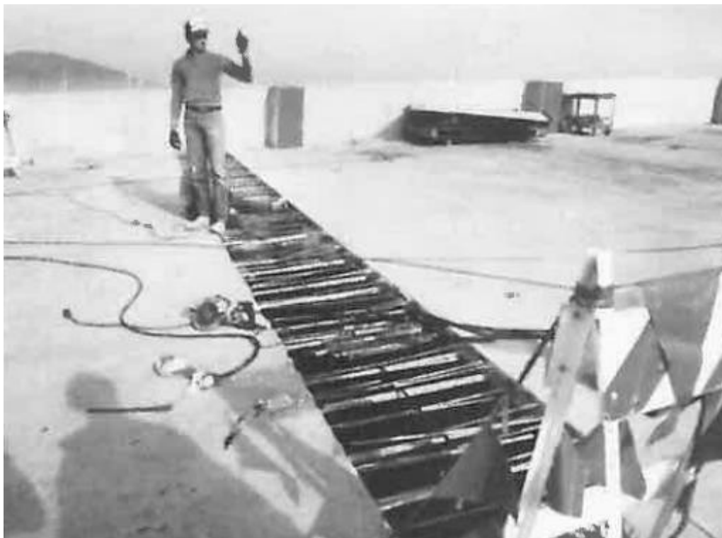
Figura 36 - Remoção do concreto na laje
