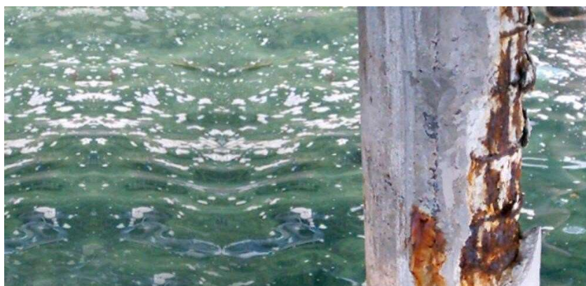
Figura 16 - Ataque de cloretos em região marinha
