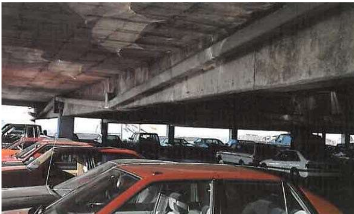
Figura 31 - Infiltração Generalizada na laje
