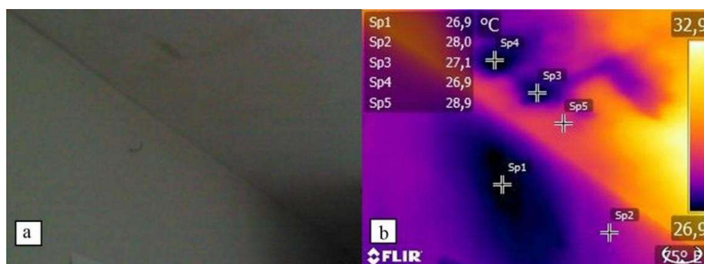
Figura 24 Superfície de parede em ensaio de termografia
