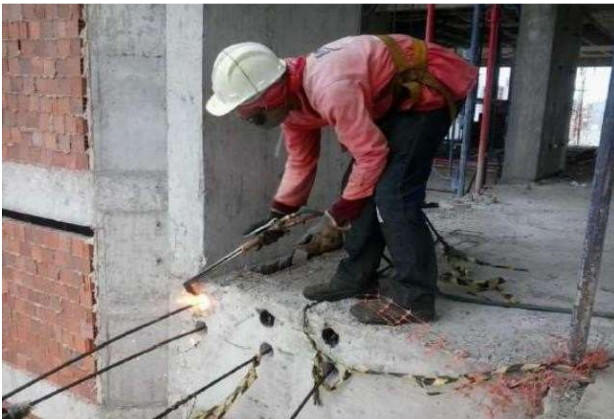
Figura 11 - Funcionário cortando cordoalha com maçarico
