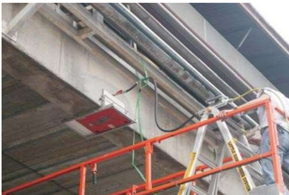
Figura 23 - Ensaio de tomografia ionizante em viga
