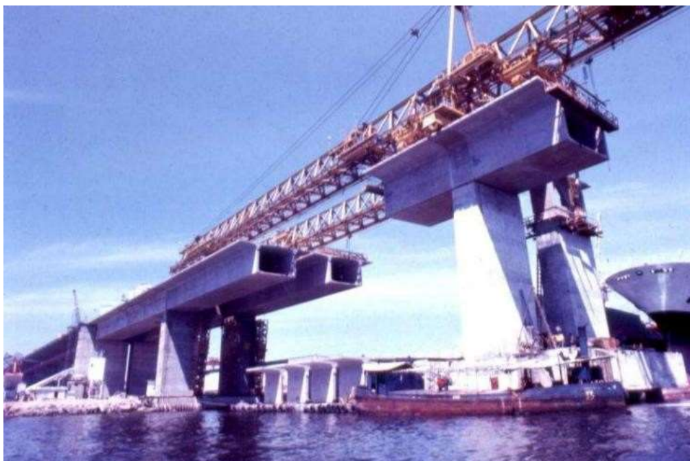
Figura 41 - Montagem das aduelas
