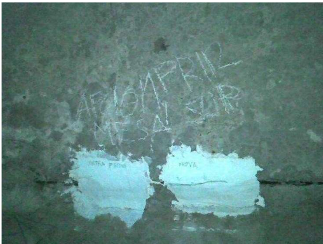
Figura 44 - Fissuras na região da mesa superior
