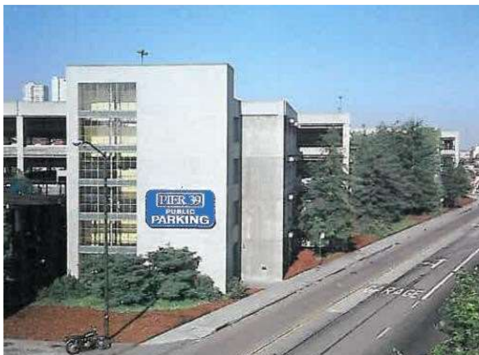
Figura 29 - Visão lateral do estacionamento
