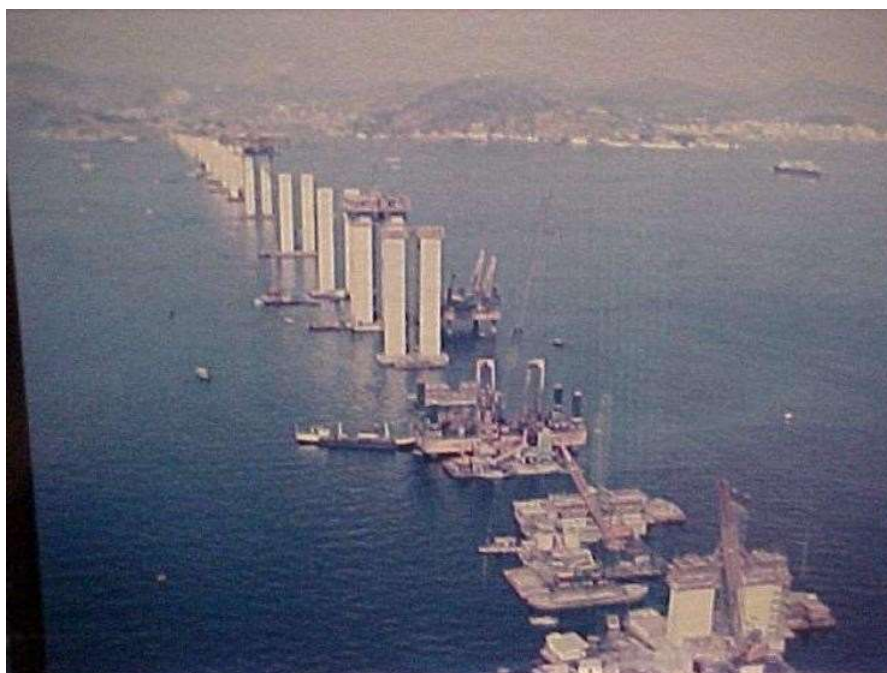
Figura 40 - Construção da Mesoestrutura da ponte
