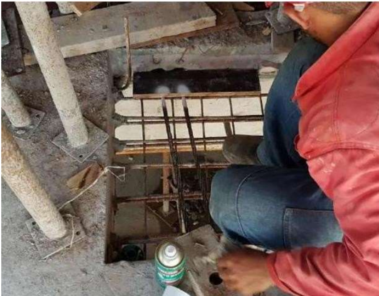
Figura 10 - Aplicação do spray de secagem
