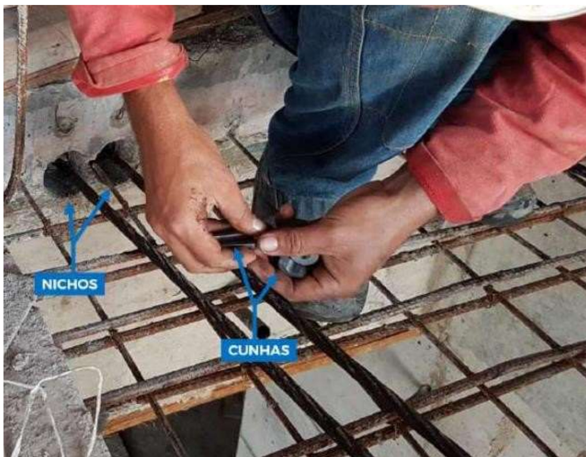
Figura 9 - Aplicação de cunhas na ancoragem ativa
