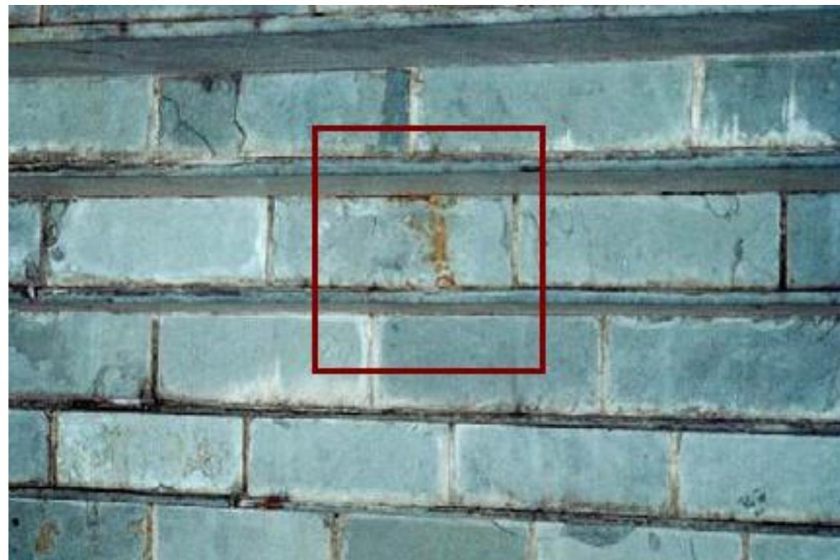
**Figura 18:** Ardósia verdes com manchas de ferrugem resultantes da alteração de sulfetos..
