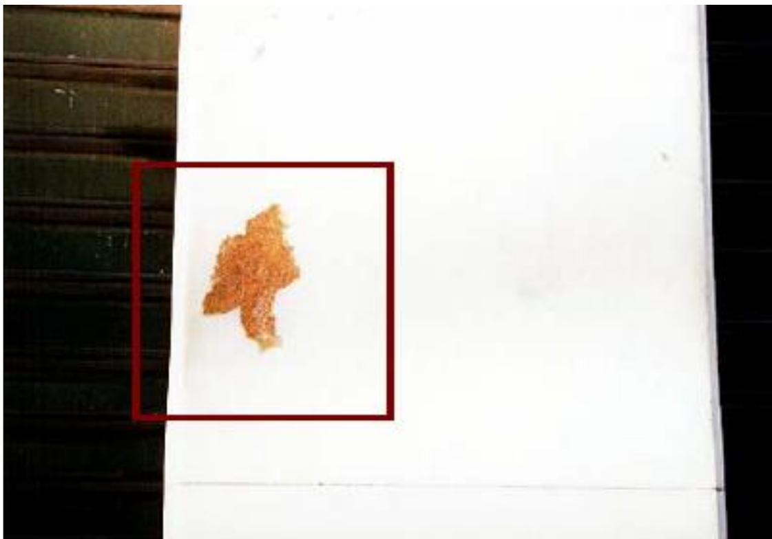
**Figura 17:** Mancha de ferrugem em mármore de fachada comercial revestida com mármore branco.
