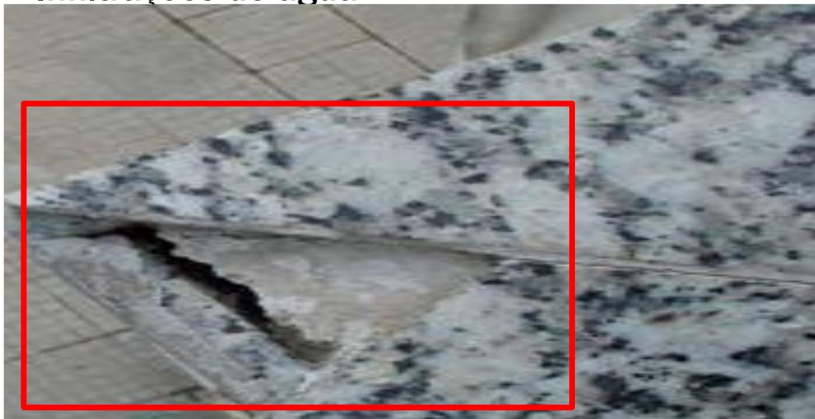
**Figura 6:** Detalhe da fachada de um edifício onde é possível ver a fraturação dos cantos de placas de pedras:
