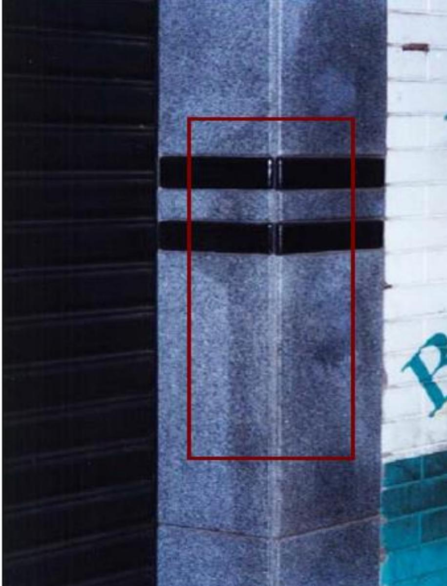
**Figura 11:** Aparecimento de manchas nas placas de granito provocadas pelas águas das chuvas que perola juntas mal rejuntadas
