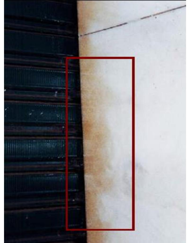
**Figura 16:** Mancha acastanhada devido à liberação de óxidos e hidróxidos de ferro (ferrugem) por porta de ferro e sua infiltração por meio de soluções em mármore branco.
