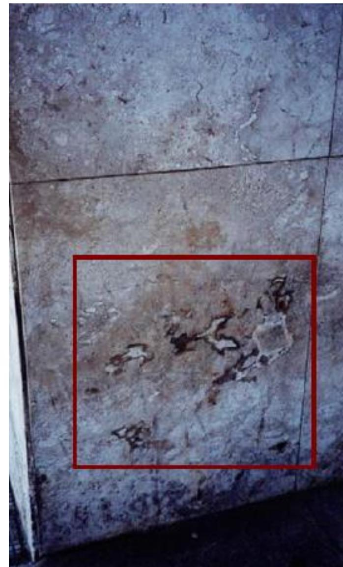
**Figura 15:** Mancha de resina usada como selante de superfície de placa de mármore em fachada residual.
