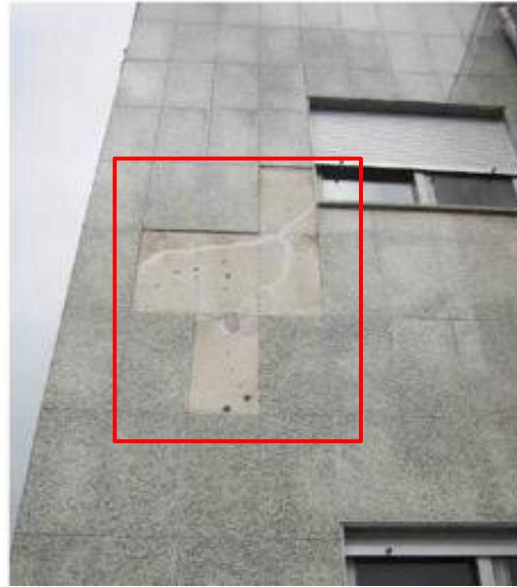
**Figura 5:** Fachada de edifício onde é visível o destacamento de várias placas de pedras
