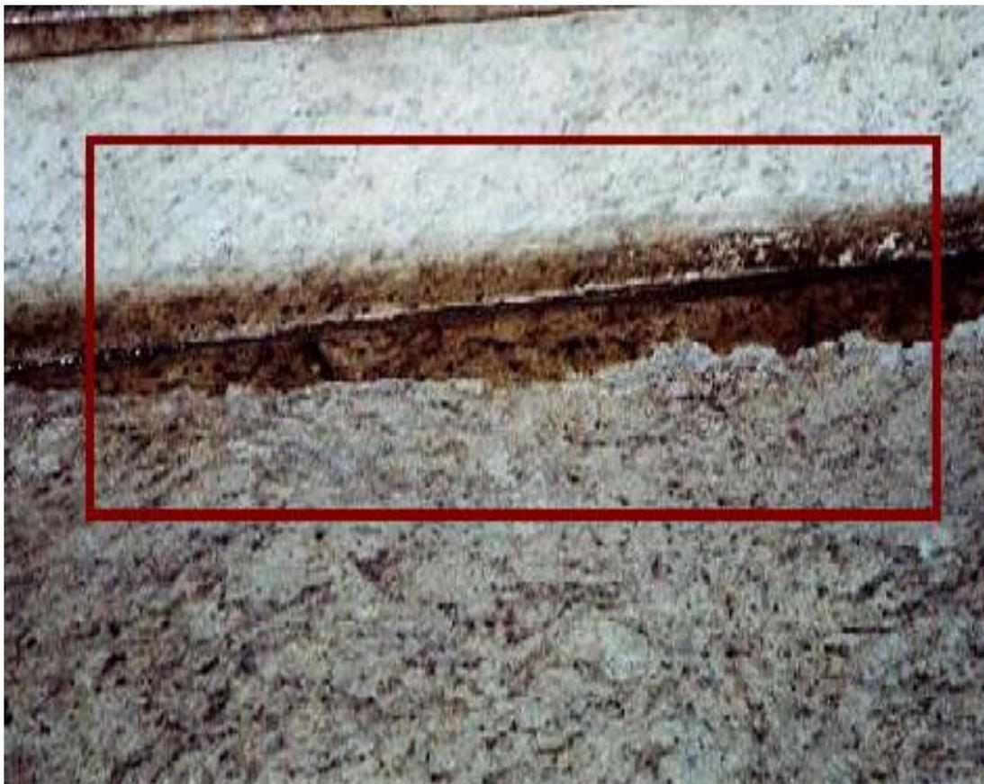
**Figura 14:** Mancha em granito devido à aplicação excessiva de selante em juntas
