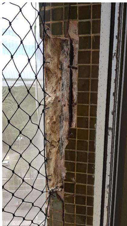
Pilar com corrosão de armaduras observando-se que, praticamente, não se teve cobertura e a fixação das telas de proteção colocou chumbadores metálicos de potenciais diferentes em contato (corrosão galvânica). Observou-se que, mesmo com um revestimento argamassado de quase 10 cm (dez
