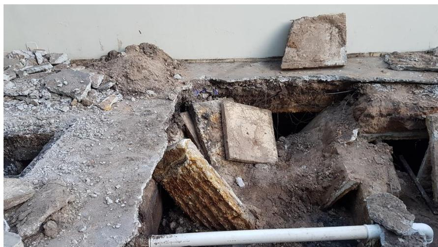
**Características do Sistema de Tratamento Primário dos Esgotos do Edifício:** fossa e filtro contíguo em concreto armado com tampas em concreto armado pré-moldado.
