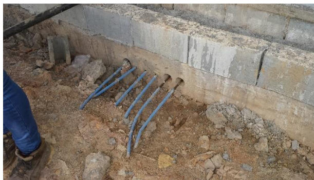
FOTO 9. Exposição agressiva desnecessária dos cabos protendidos nas ancoragens de uma fundação em radier protendido.
