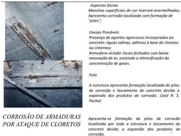
FOTO 2. Estrutura de concreto reticulada sob ataque também de cloretos.
