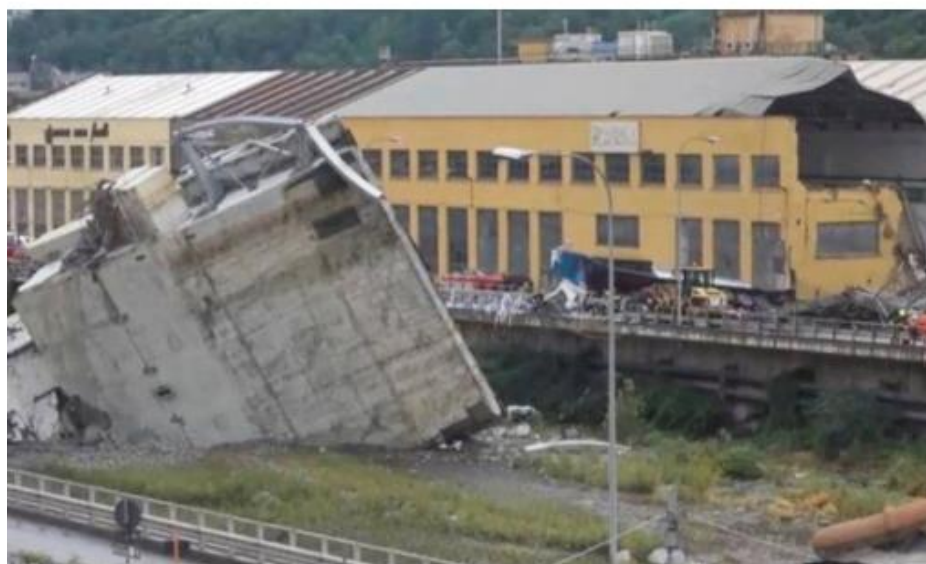
Pedaço da ponte Morandi, em Gênova, após queda; construção dos anos 1960 passava por trabalho de manutenção no momento do acidente Foto: REUTERS IV / REUTERS
