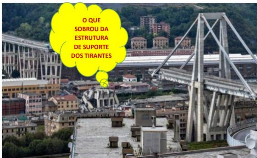
Trecho da Ponte Morandi, em Gênova, desmoronou - PIERO CRUCIATTI / AFP
