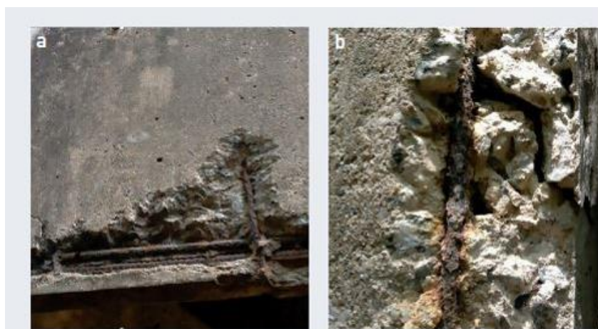
Fig. 2. Armadura com corrosão generalizada em quinas de viga e pilar.
