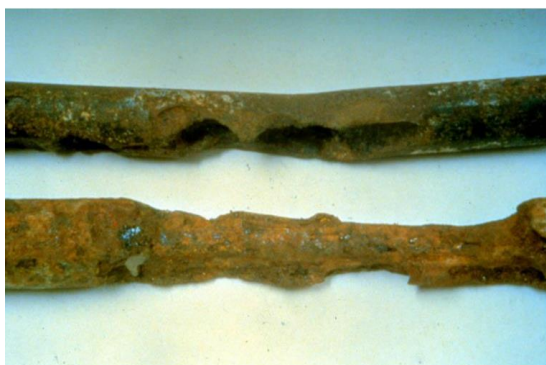
FOTO 11. Armaduras de aço carbono comum corroídas por pites devido ação dos cloretos
