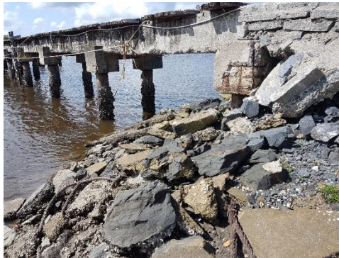
FOTO 3. Ponte no município de Indiaroba/Se. Componentes de infra e superestrutura em concreto armado com corrosão visível instalada.
